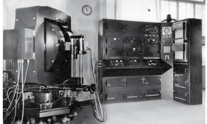
um 1963 TTC-Kernresonanz-Spektrometer KIS2, bestückt mit Elektromagnet von hoher Feldhomogenität.
