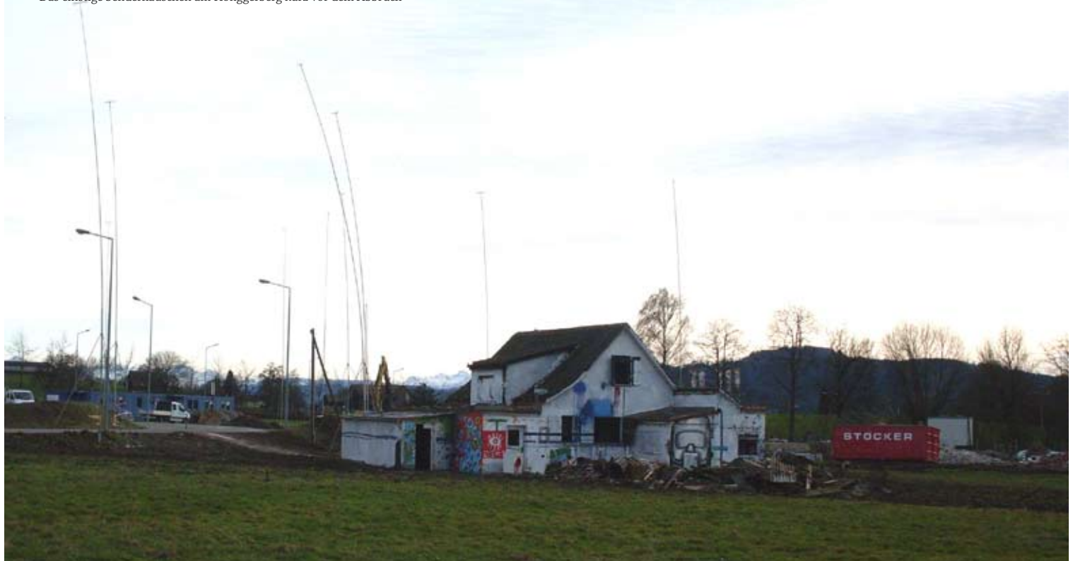
Das einstige Senderhäuschen am Höneggerberg kurz vor dem Abbruch
