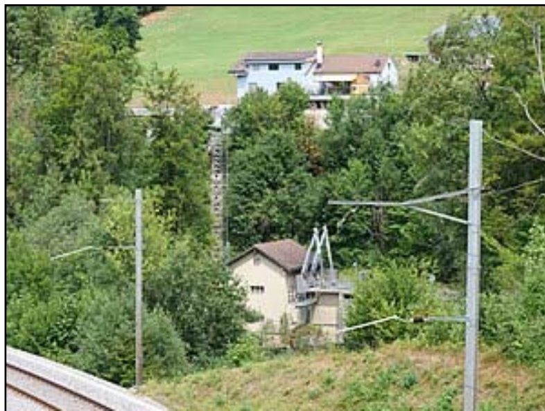
Kraftwerk «Herrentöbeli» in Krummenau (SG)
