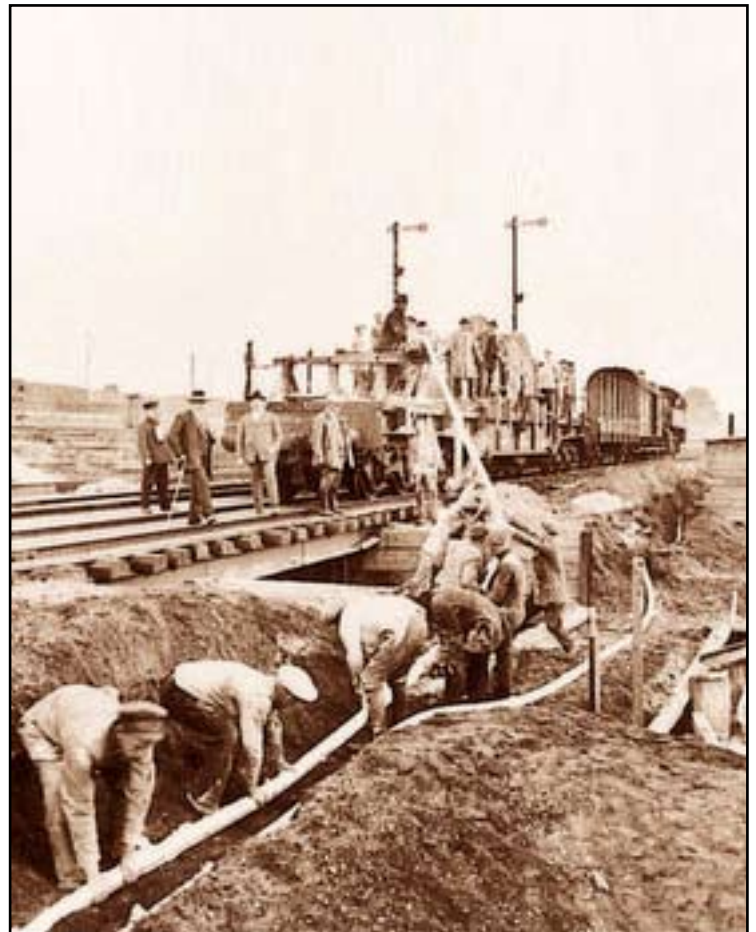
unten: Verlegen einer Telegafenleitung entlang der Eisenbahn-Linie
